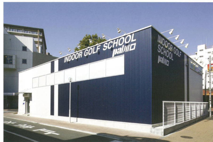
(スポーツ施設)
